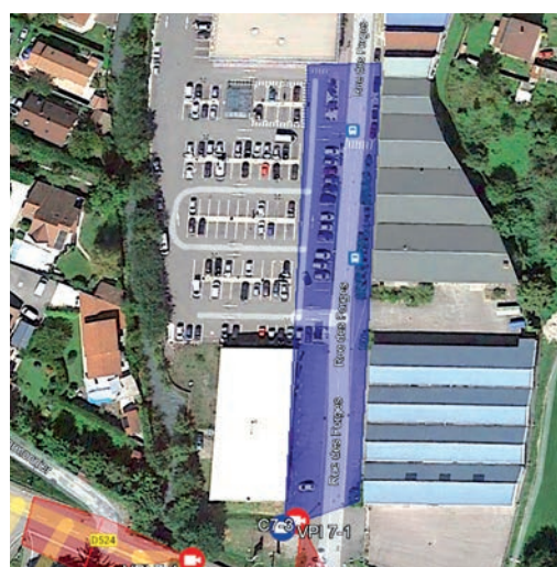
Zone de la rue des Forges où l'installation des caméras est prévue courant 2023.
