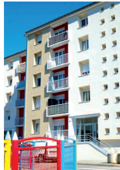
D'importants chantiers d'isolation des bâtiments du parc de logements du LPV ont dernièrement bénéficié aux locataires des bâtiments des Cités Liberté et Cachin.
